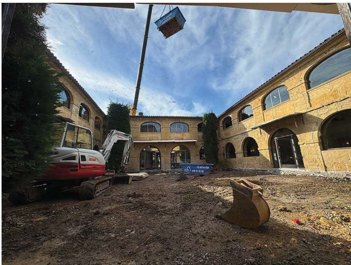
Los trabajos en el patio del claustro del Monasterio de San Pedro Villanueva, hoy Parador de Cangas de Onís, se han paralizado.
